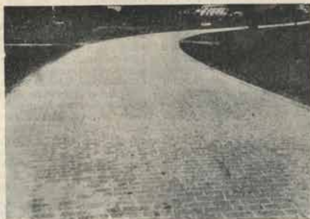
Одна из лучших современных дорожных одежд — клинкерная, из специальной глины, обожженной до состояния спекания
